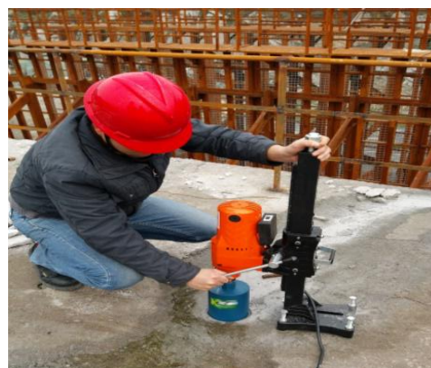
图 2.4-6 充填体现场取样
