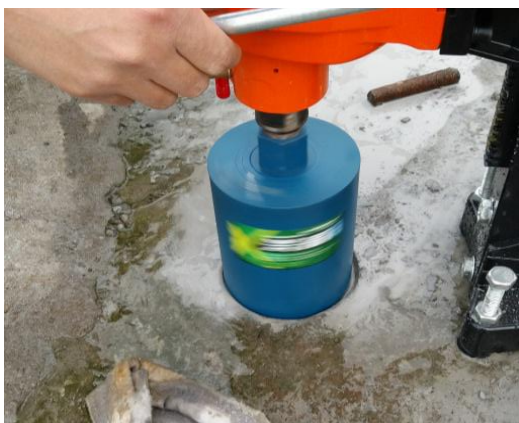
图 2.4-5 充填体现场取样
